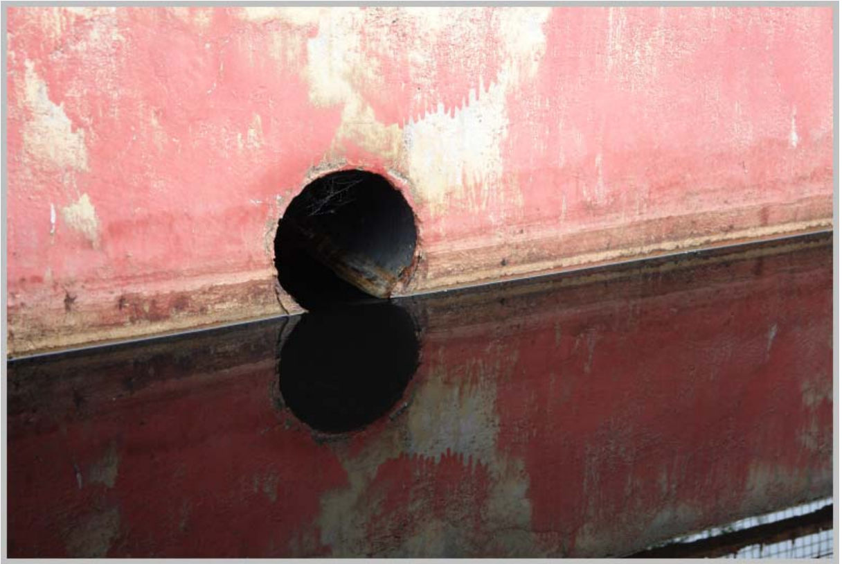
Το στόμιο υπερχείλισης της δεξαμενής Ι.
