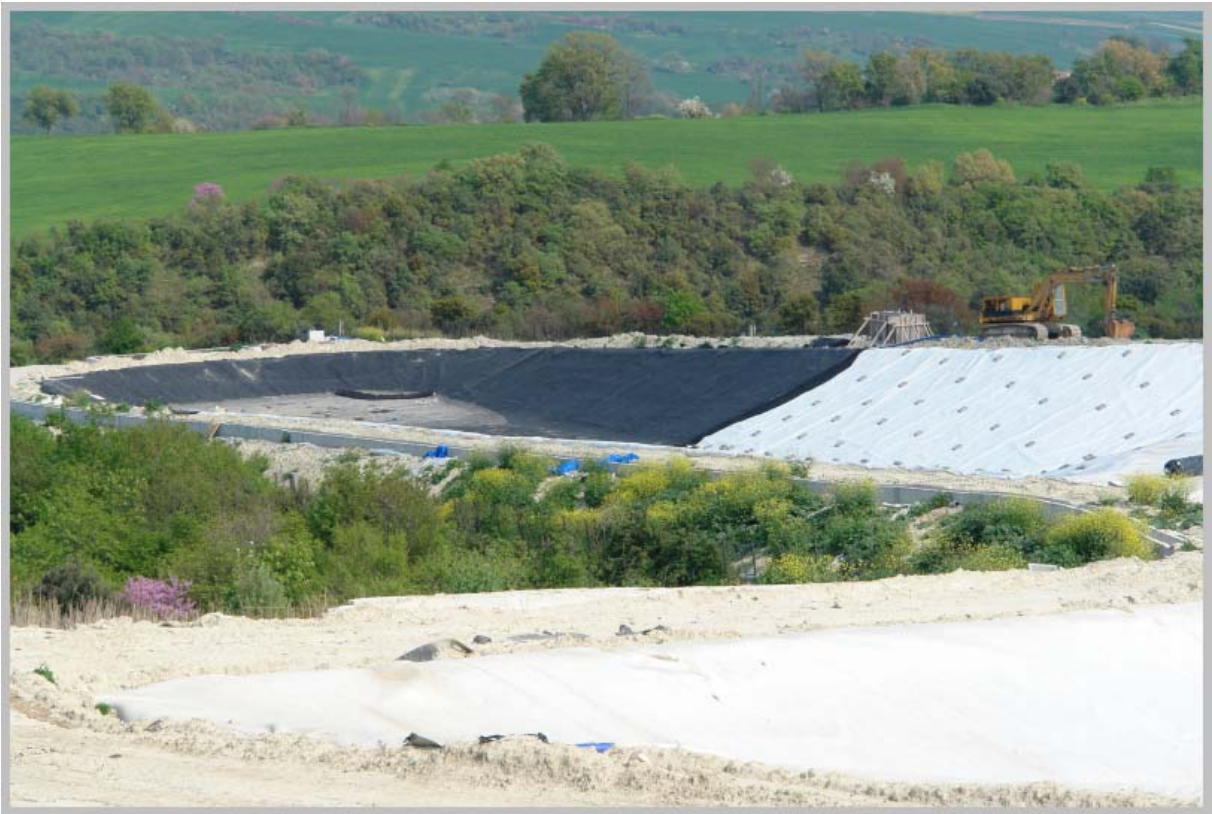
Το φάτνωμα Φ3 εμβαδού 5.160 τ.μ. πριν την ολοκλήρωση στις κατασκευής του (11.04.2010).
